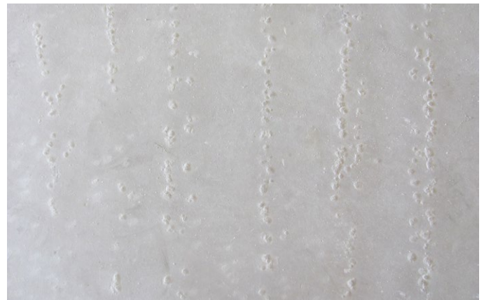
Abb. 19: Beispiel für die Bläschenbildung an der Oberfläche von Fließestrichen
